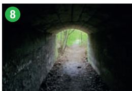
8 Tunel Na Kobyle
