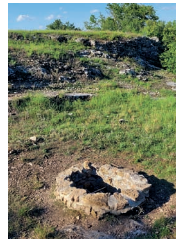
Vyústění komína na Zlatém koni
